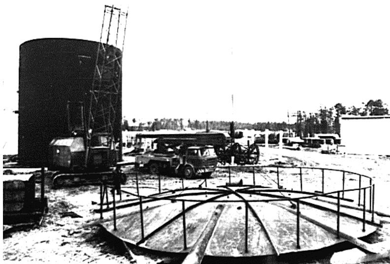
Рис. 2. Купольное покрытие РВС – 1000 м 3
