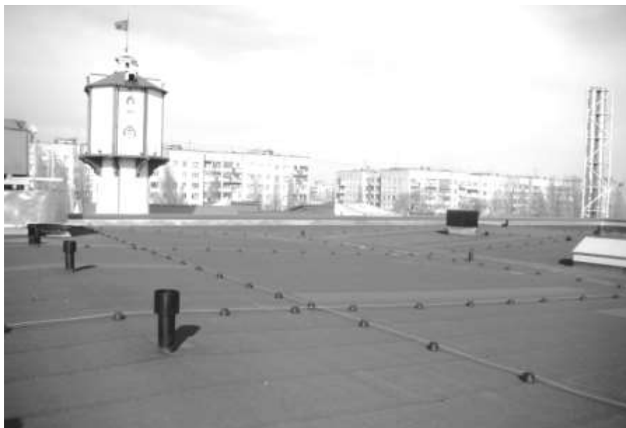
Рис. 3. Фрагмент общего вида кровли одноэтажного промышленного здания
