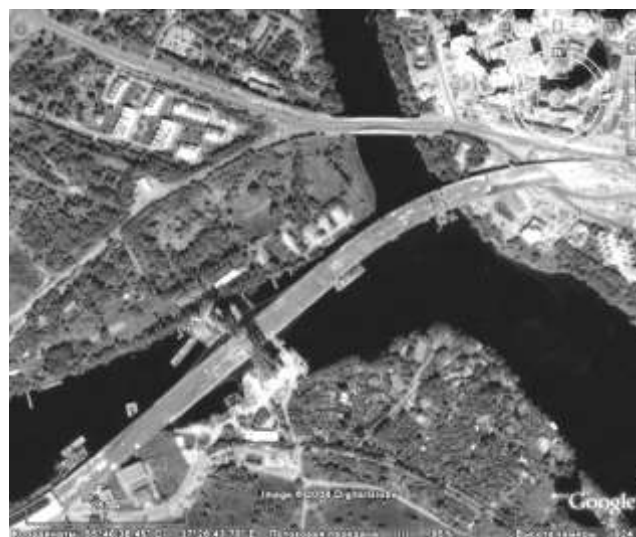
Строящийся мост через Москву-реку
