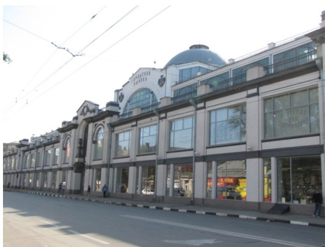
Рис. 5. Здание Крытого Рынка. Архитектор В. А. Люкшин
