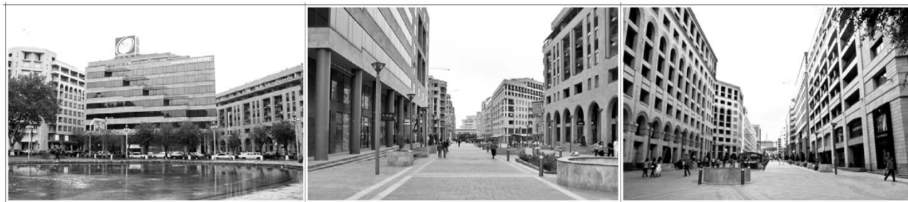
Рис. 2. Застройка Северного проспекта. Трансформация периметральной застройки прошлого в неопределенную структуру препятствовала достижению композиционной целостности
